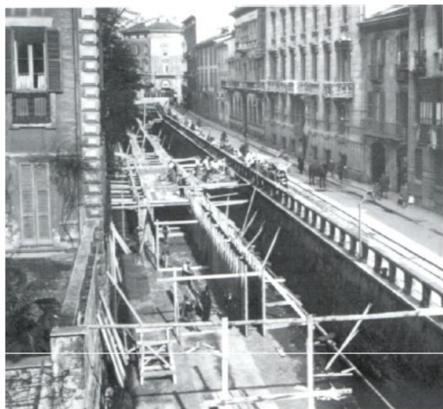
Copertura della Fossa Interna (1929-30)
