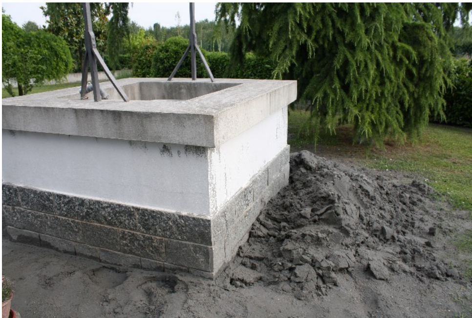
Fig. 6 – Accumulo di sabbia espulsa da un pozzo (già ripulito) a Sant'Agostino (FE)
