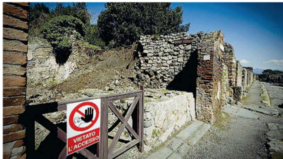
Il cedimento Nella notte tra domenica e lunedì si è sbriciolata la parete di contenimento alta 2 metri in un'area non scavata di via Nola (Ansa)
