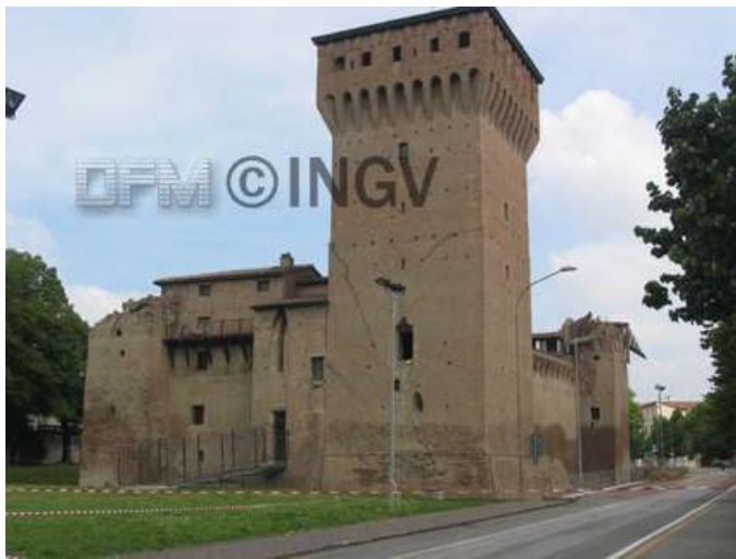
Foto 7. San Felice sul Panaro Grave danno ad edificio monumentale
