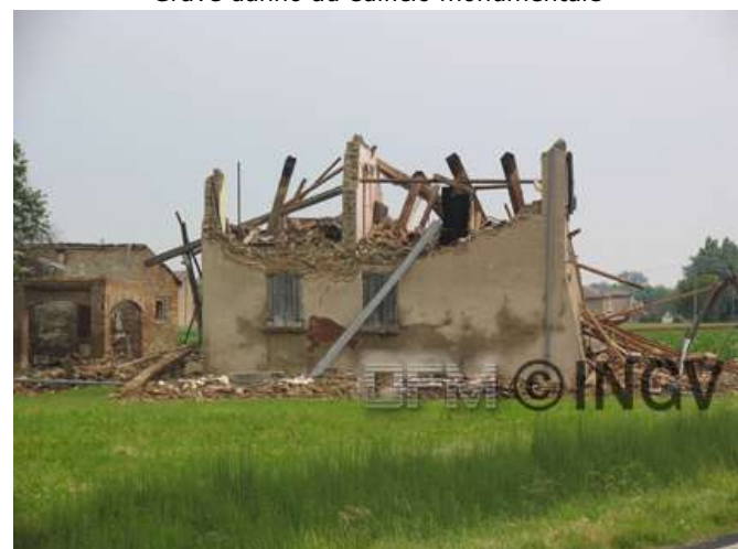
Foto 9. Sulla strada verso Alberone Crollo edificio di tipo A
