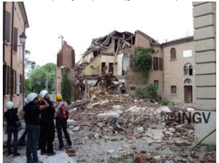
Foto 8. San Felice sul Panaro Crollo edificio di tipo A
