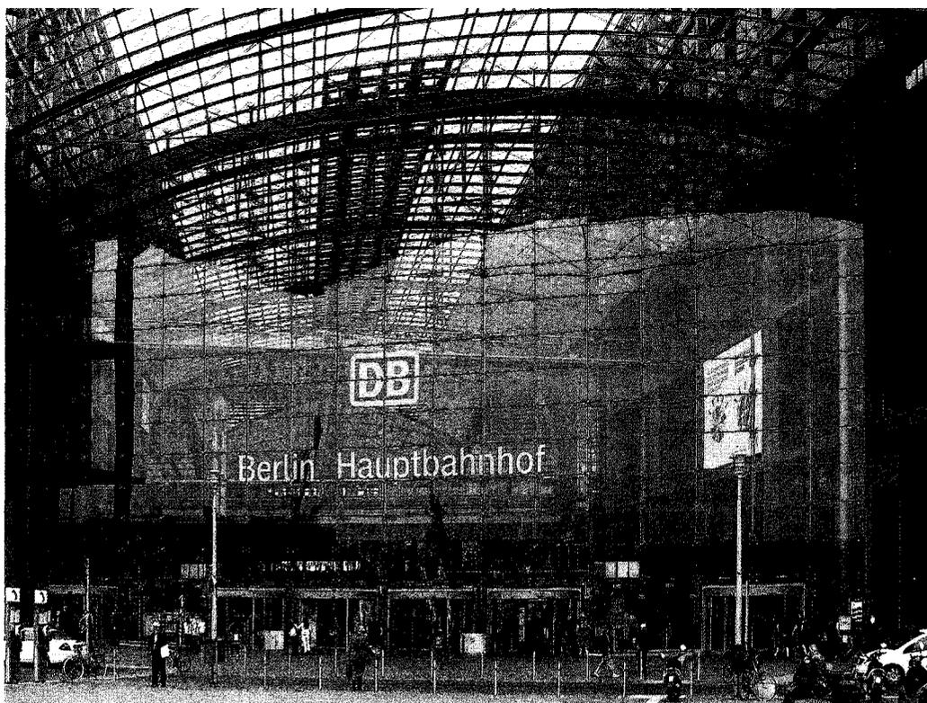
**Bioarchitettura.** Il tetto della stazione centrale di Berlino è rivestito con 780 moduli solari e 78.000 potenti celle solari trasparenti
