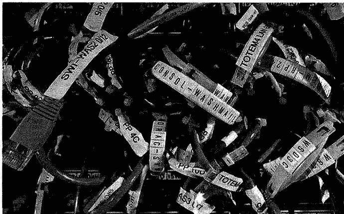
Un groviglio di cavi utilizzati per la connessione telefonica e Internet (immagine tratta dal sito daily.wired.it )
